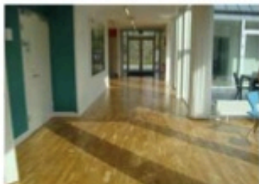
F17: Beboergang i træ. Bolig K og L til venstre. Niche til højre med udsyn til gårdhave og tværgang. Himmelport lige fremme.
