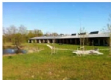
F12: Hospices landskab set ude fra vest. Kyssebænken er placeret på den flise-belagte platform til højre.
