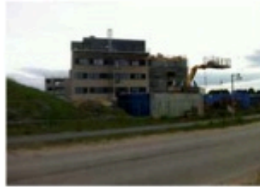
F10: Byggeplads i bevægelse mod hospices østvendte side.
